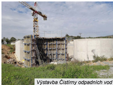
Výstavba Čistírny odpadních vod
