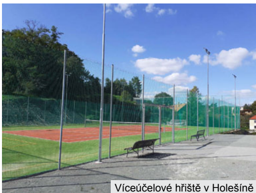
Víceúčelové hřiště v Holešíně
