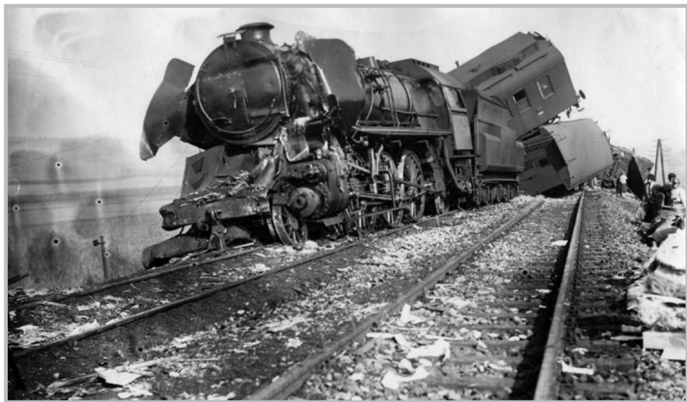
Nárazem poškozená a vykolejená lokomotiva č. 387.021 v čele nákladního vlaku č. 8610 – pohled směrem k Doubravici n. Svít. (MZAB)
