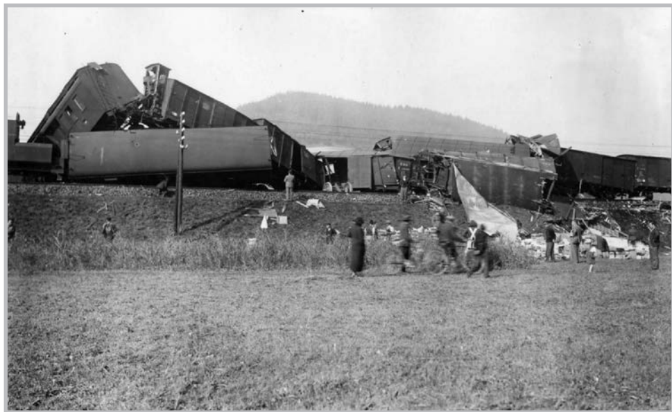
Demolované vozy vlaku č. 8610 – pohled kolmo na trať směrem k západu (MZAB)
