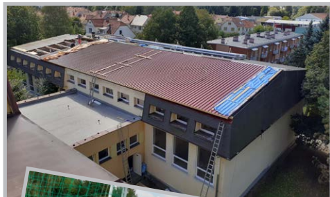
Nová střecha na tělocvičně Základní školy
