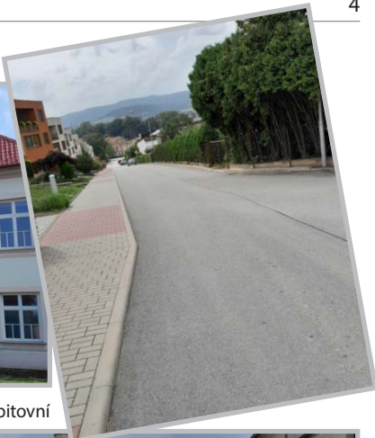
Rekonstrukce ul. Budovatelů
