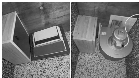
Instalace tlumícího modulu vzduchového systému
