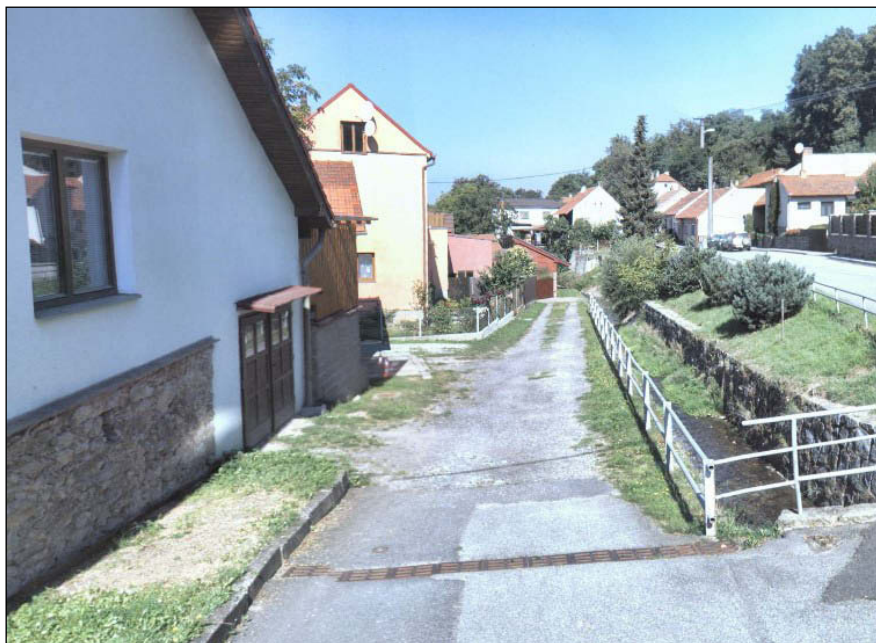
Jak se mění naše město – místní část Holešín, oprava povrchu komunikace.
